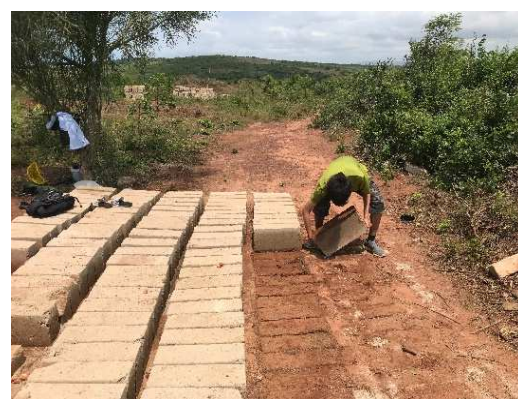
ほとんど人力での作業
